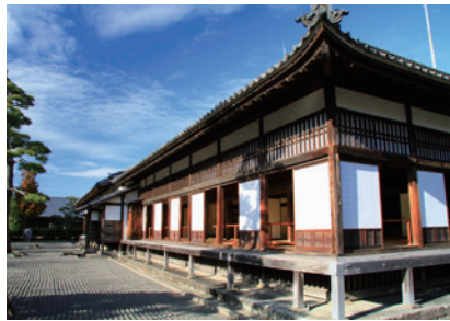
掛川城御殿は江戸後期の建築で、全国でも4カ所しかない現存する城郭御殿
